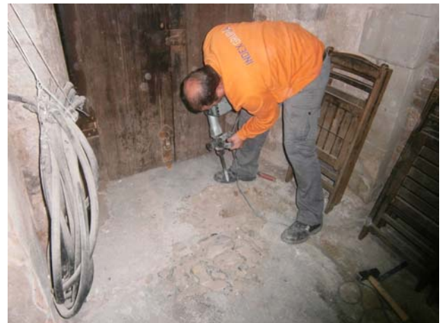
FOTO 12 – Sondeig interior Sant Pau del Camp. Inici dels treballs resseguint el traçat de la rasa del 2007
