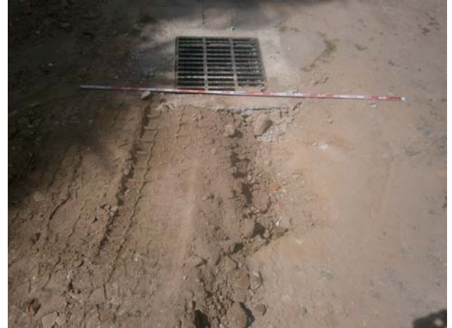
FOTO 10 – Jardí de Sant Pau del Camp. Detall del pericó sífonic existent.
