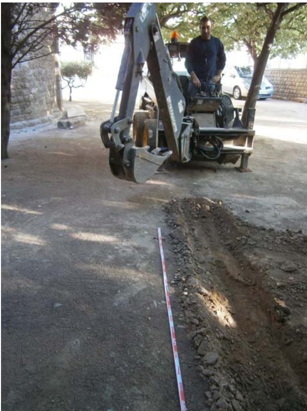
FOTO 3 – Jardí de Sant Pau del Camp. Inici del treball d'excavació resseguint el traçat de la rasa existent.
