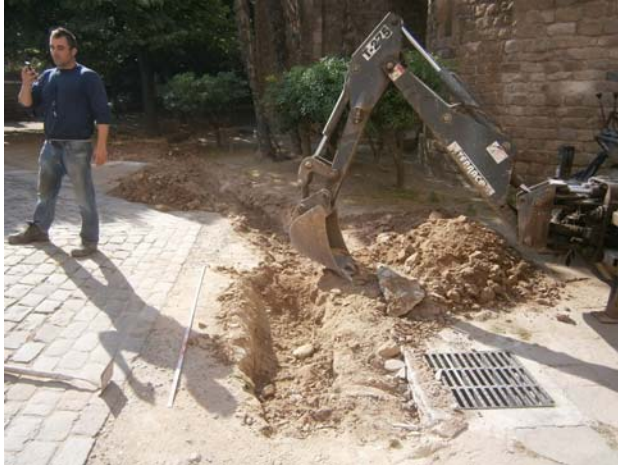
FOTO 9 – Jardí de Sant Pau del Camp. Finalització de la rasa en arribar al pericó sífonic proper al carrer Sant Pau.
