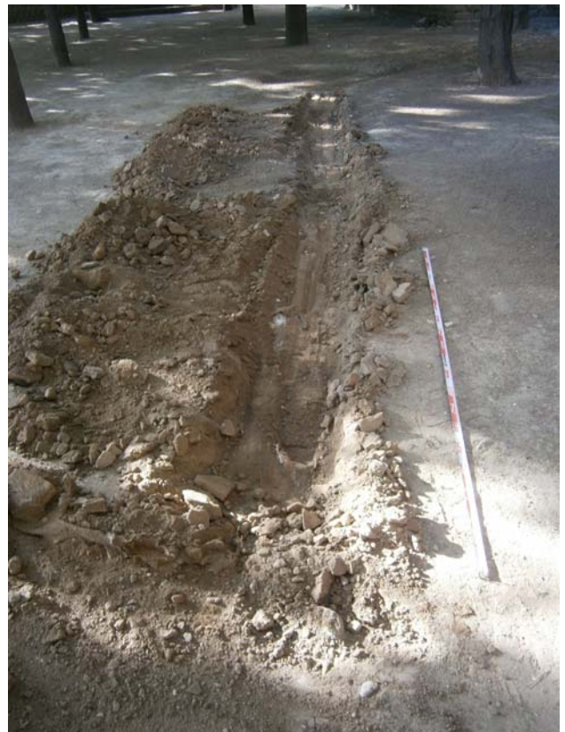
FOTO 4 – Jardí de Sant Pau del Camp. Material de rebliment de la rasa, argila i runa constructiva sobre teixit geotèxtil.
