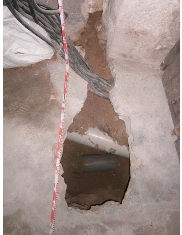
FOTO 14 – Sondeig interior Sant Pau del Camp. Localització dels dos tubs de PVC.
